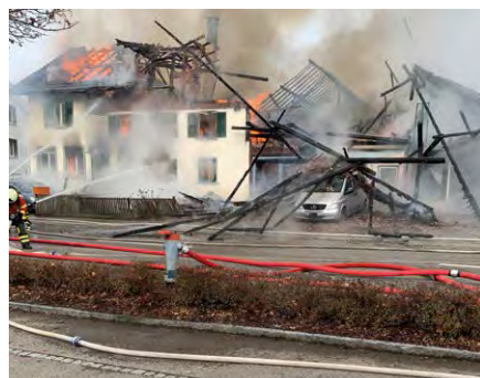
14.12.2020, Guntershausen bei Aadorf Wohnhaus Werkstatt
